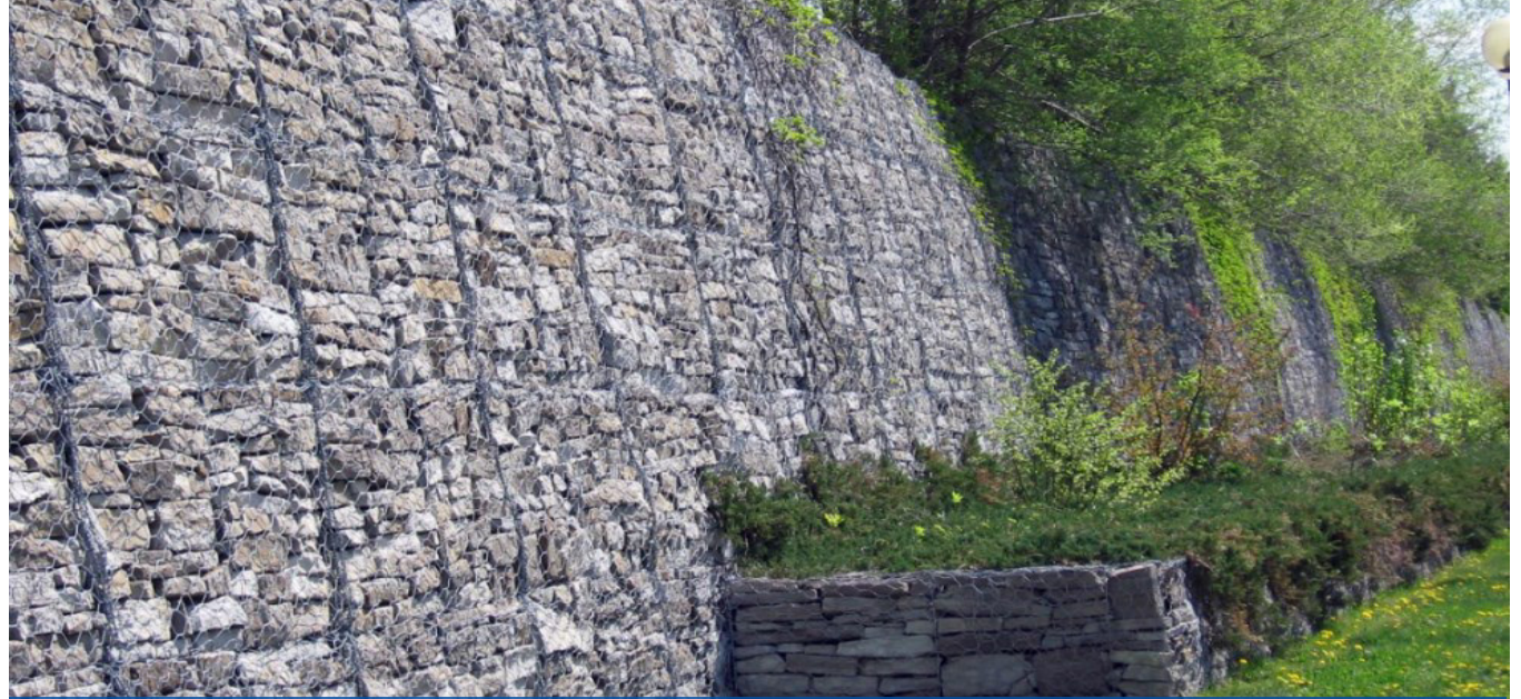
Contenção à Gravidade em Gabiões
