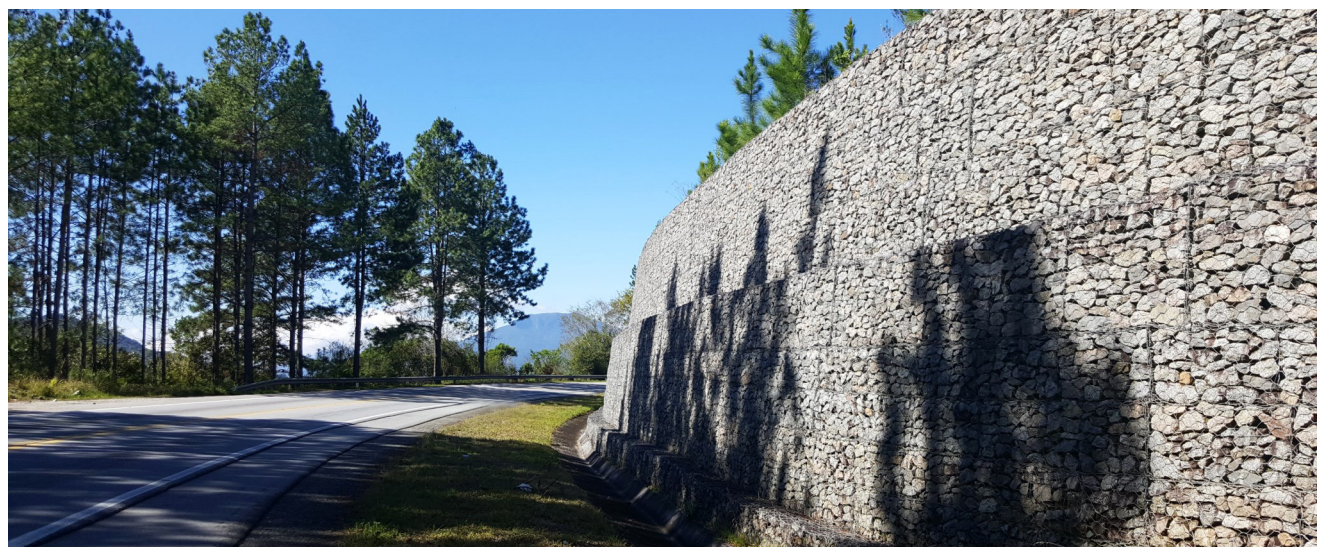
Contenção à Gravidade em Gabiões
